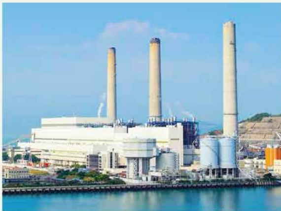
Planta generadora de energía.
