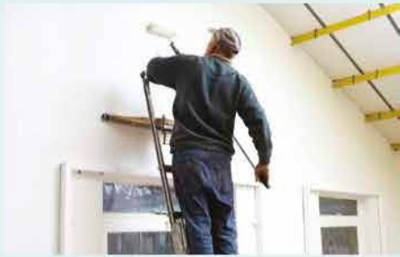
Escalera sobre una pared.
