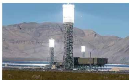
Figura 34.1 Granja solar ubicada en Ivanpah Dry Lake, en California, EUA. Es la más grande del mundo; cuenta con 300 000 espejos y provee de electricidad a 140 000 casas.
